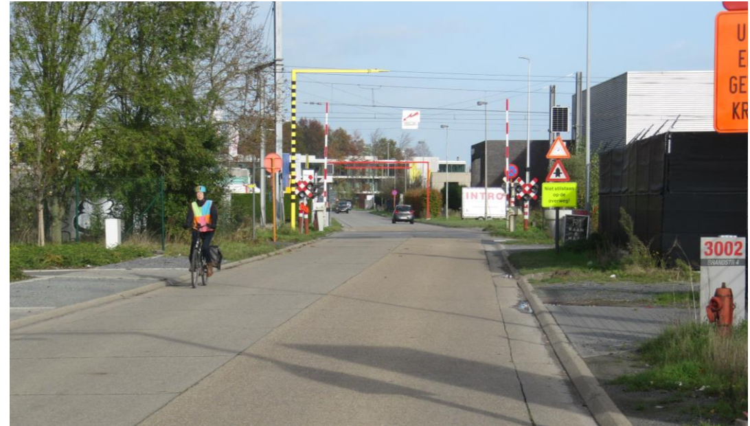
Overweg Brandstraat (OW 30)
