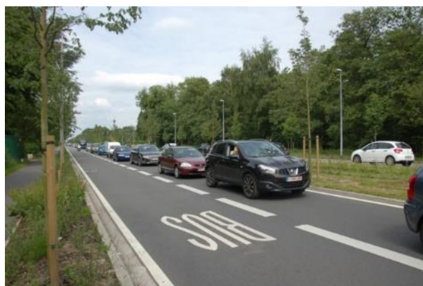
Figuur 22: Busbaan Bredabaan, Antwerpen (Bron: Nieuwsblad)
