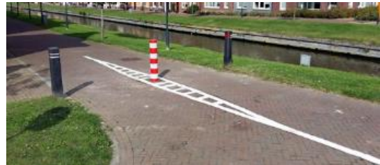
Figuur 14: Fietssluis (Bron: Google)
