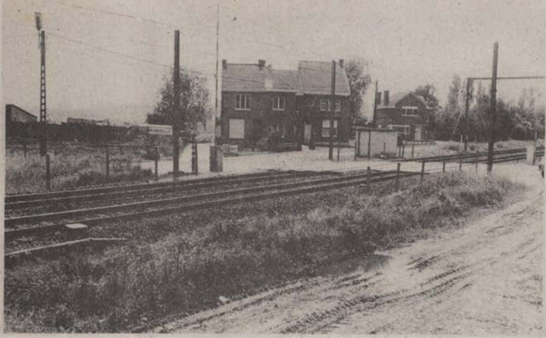
zone 7 : hier eindigt de binnenring St-Niklaas vanuit het centrum (rechts) en moet over de spoorweg Antw.-Gent overgaan in RW60.
