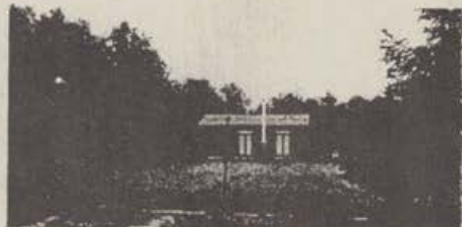
Naast de 2 tennisterreinen werd ook een riante chalet opgetrokken voor tennisklub «De Zilverberk» achter de Kemzeekse Wal. Dit bouwwerk staat er illegaal. De eigenaar is bereid het zonder meer te slopen, op voorwaarde dat ook alle andere illegale bouwsels uit Stekene worden gesloopt.
