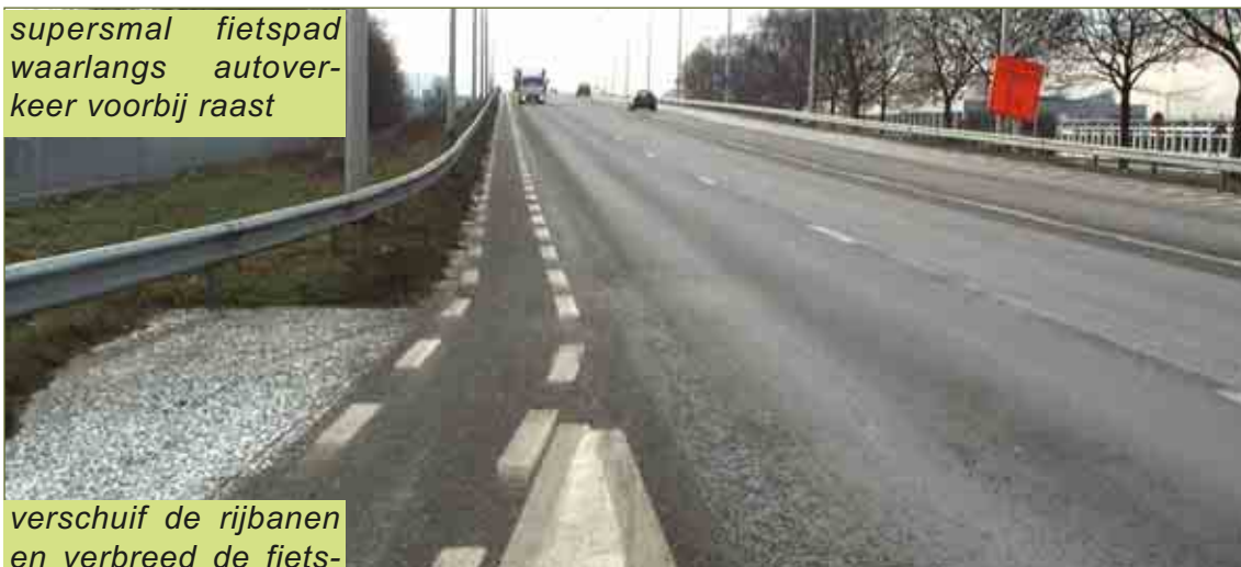
vernieuwd kruispunt ; zelfs hier op de N70 mochten de nieuwe fietspaden toch iets breder zijn : 2.20 m is aangegeven op zo'n belangrijke route.
