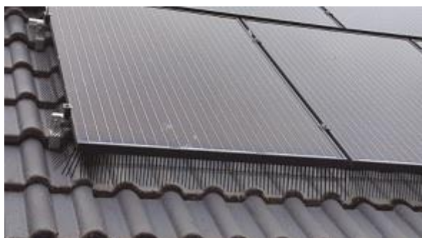
Figuur 6: Vogelschroot belet o.a. huismussen om onder zonnepanelen hun nestplaats te maken ( https://www.materialenvoordebouw.nl/Zonnepanelen_toebehoren/Zonnepaneel_vogelwering ).
