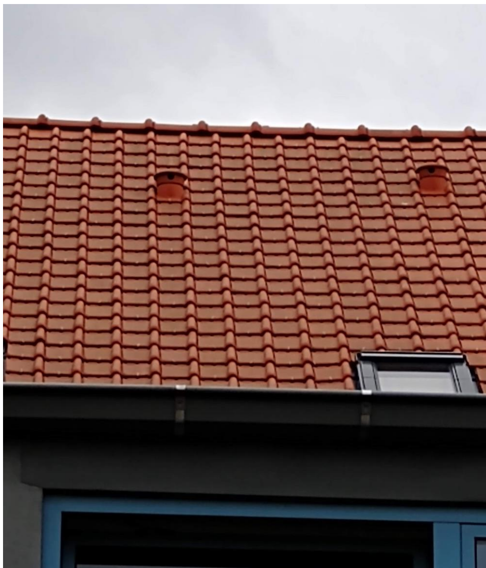
Figuur 44: Mussenpannen op het dak van Goedendaglaan 69 (eigen foto)
